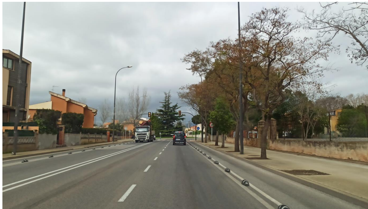
Figura 3. Exemple de carril bicicleta segregat en calçada a l'avinguda Falset de Reus
