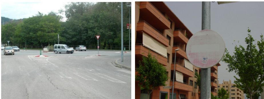
Imatge 77 Senyalització en estat deficient
