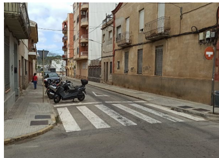
Imatge 10. Degradat de la marca de pas de vianants per poca dotació al C. de Barcelona
