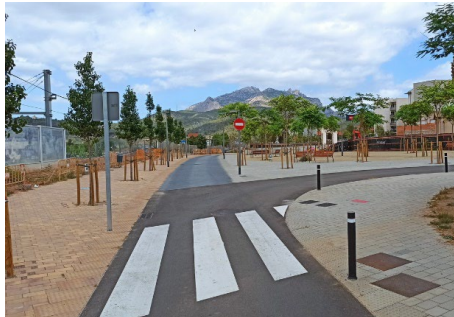
Imatge 33. Pas de vianants accessible per a PMR i invidents al C. de les Argelines.
