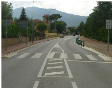
Exemple de mitjana pintada, estrenyent els carrils de circulació per moderar la velocitat. Aquí s'ha combinat amb trencament horitzontal de l'eix de la trajectòria.
