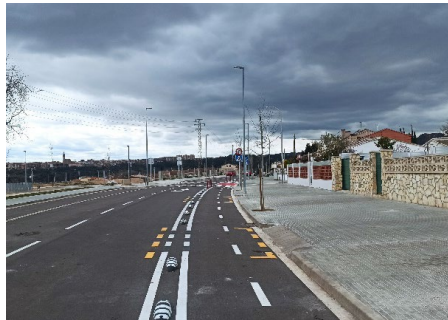
Imatge 50. Carril bici bidireccional segregat en calçada amb canvi a sentit únic de circulació a La Flora.
