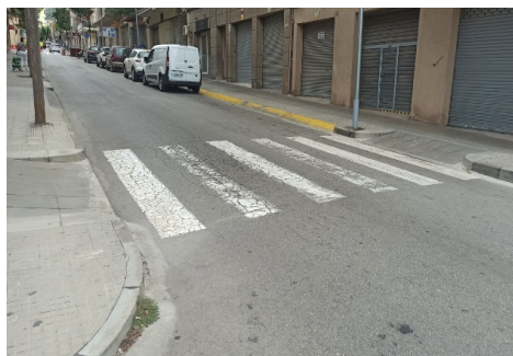
Imatge 7. Senyalització de pas de vianants degradat per culpa del ferm al C. Metge Carrera.
