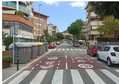
Imatge 15. Catifes d'entrada o sortida de zones compartides bici-vehicles al C. Arquebisbe Ramon Torroella.
