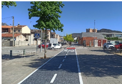
Imatge 51. Implementació de carril bicicleta compartit en calçada amb millora de la visibilitat i reducció de la velocitat en intersecció. Carrer Colom.
