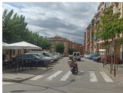
Imatge 10. Degradat de la marca de pas de vianants per poca dotació al C. de Barcelona
