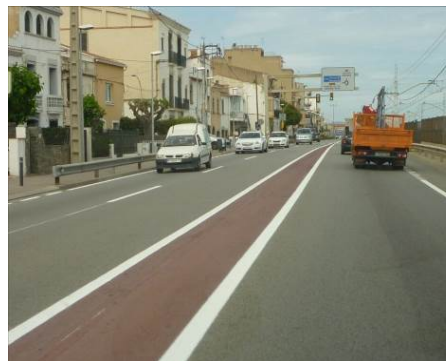
Exemple en què s'ha establert una mitjana pintada, estrenyent els carrils de circulació.
