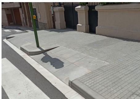
Imatge 35. Suavització dels pendents en guals de vianants i apropament dels passos a la intersecció per seguir l'itinerari natural dels vianants. C. de Lluís Puigjaner amb C. Pau Casals.
