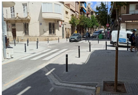
Imatge 66. Exemple de millora de la seguretat viària d'obra civil a la cruïlla entre el Carrer Colom i el Carrer Progrés.
