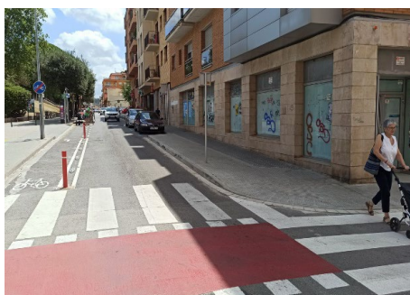
Imatge 35. Suavització dels pendents en guals de vianants i apropament dels passos a la intersecció per seguir l'itinerari natural dels vianants. C. de Lluís Puigjaner amb C. Pau Casals.
