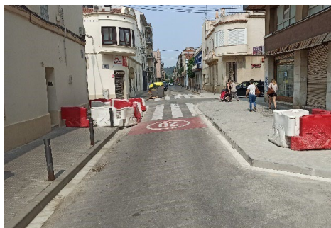
Imatge 51. Implementació de carril bicicleta compartit en calçada amb millora de la visibilitat i reducció de la velocitat en intersecció. Carrer Colom.
