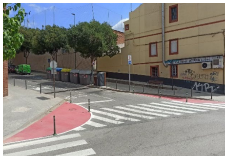
Imatge 64. Exemple de millora de la seguretat viària de vorera tàctica en cruïlles del Carrer Argelíes amb el Carrer Priorat.
